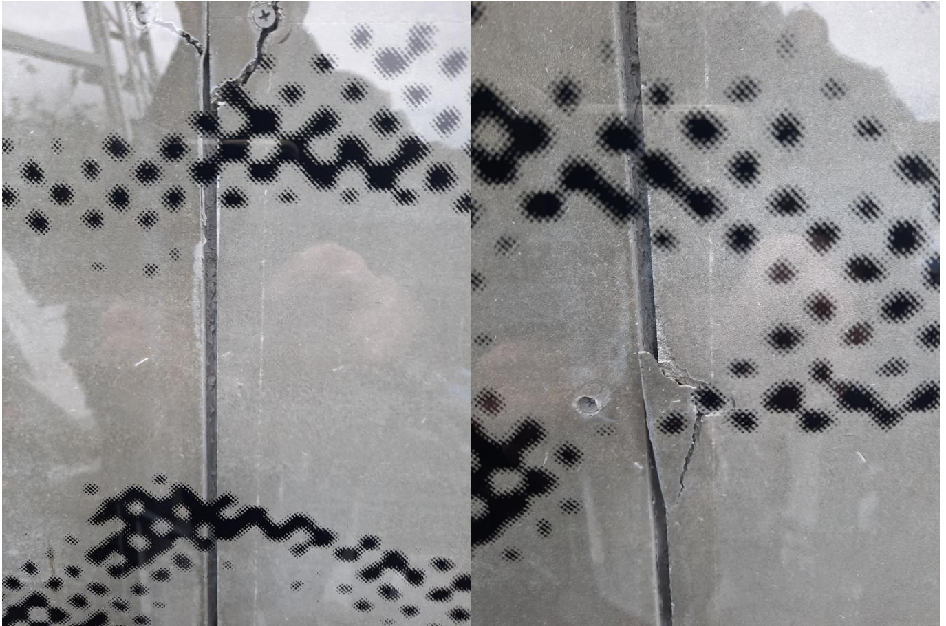
Riva í klædningi aftan fyri glasfasadu.
