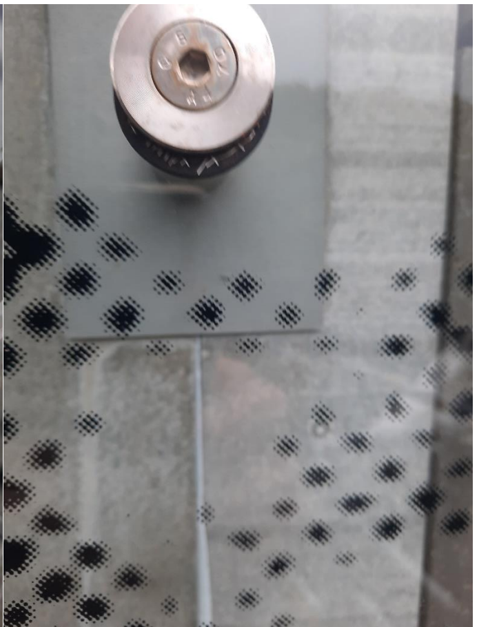
Festi, har glas er sjúnkað og gummipakningur er gliðin.
