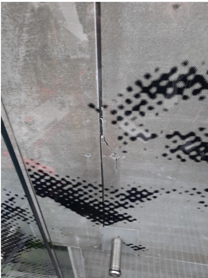
Riva í klædningi aftan fyri glasfasadu.
