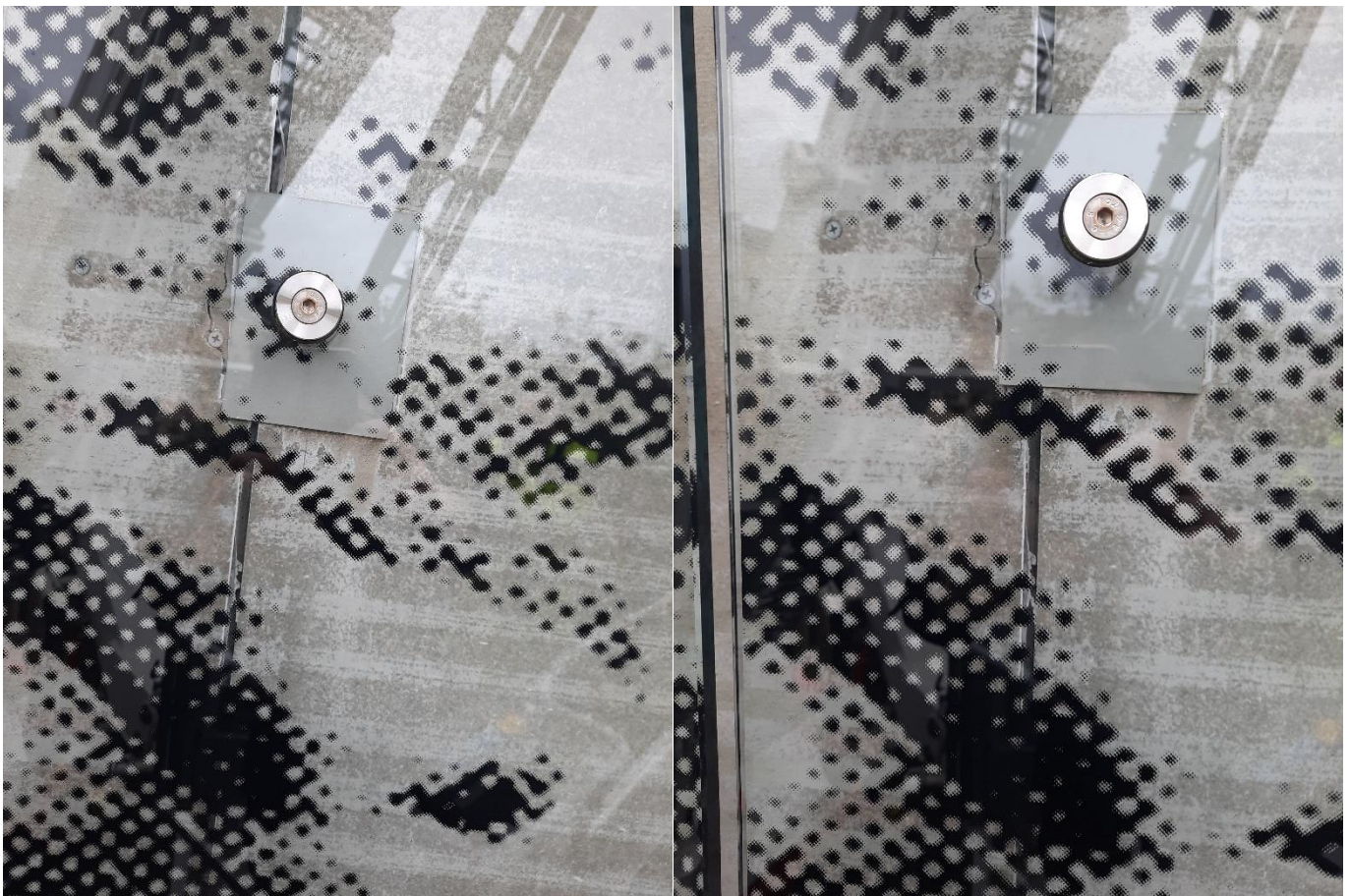
Riva í klædningi aftan fyri glasfasadu.
