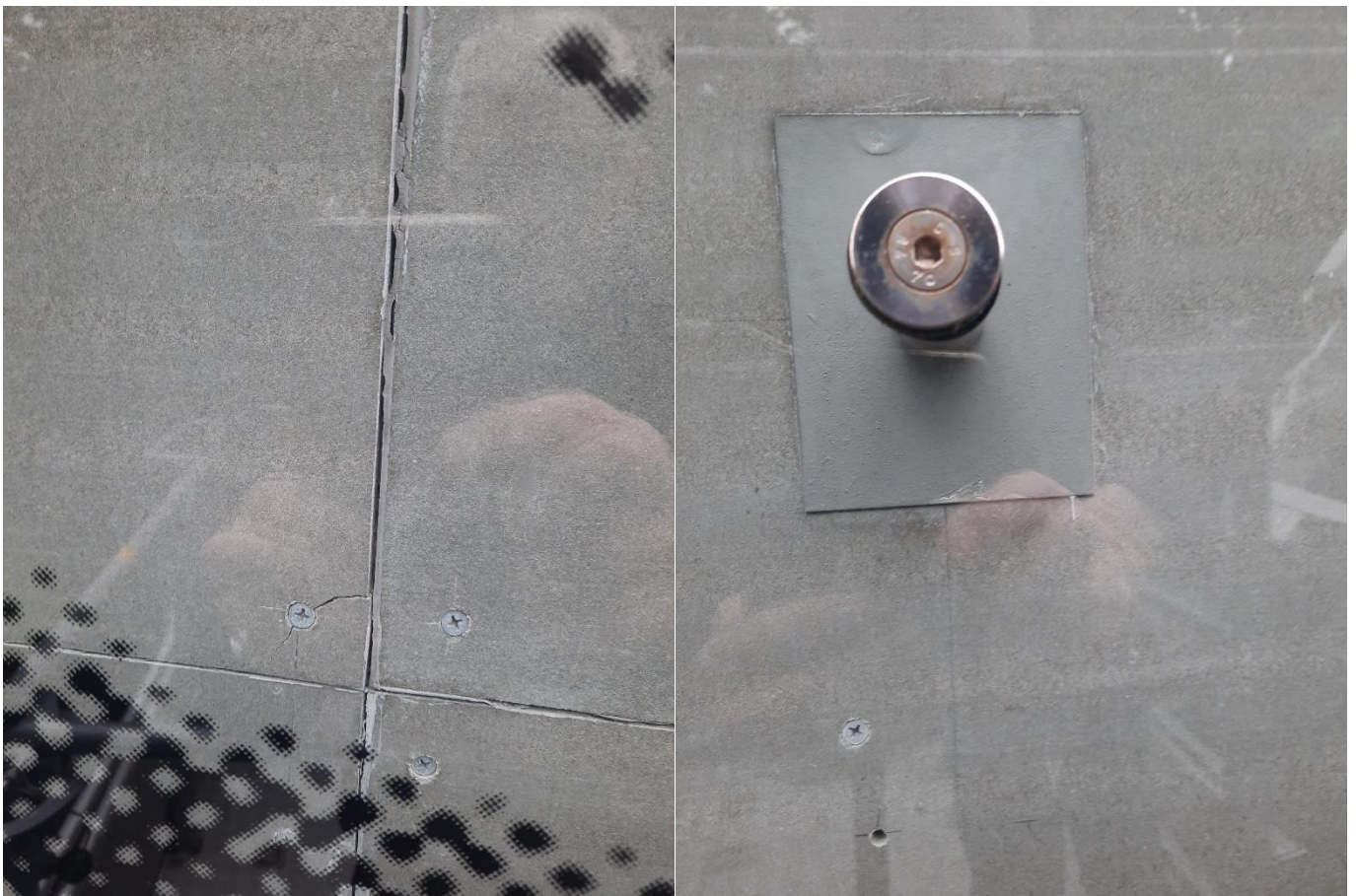
Ríva í klæðningi áftan fyrir glasfasadu.
