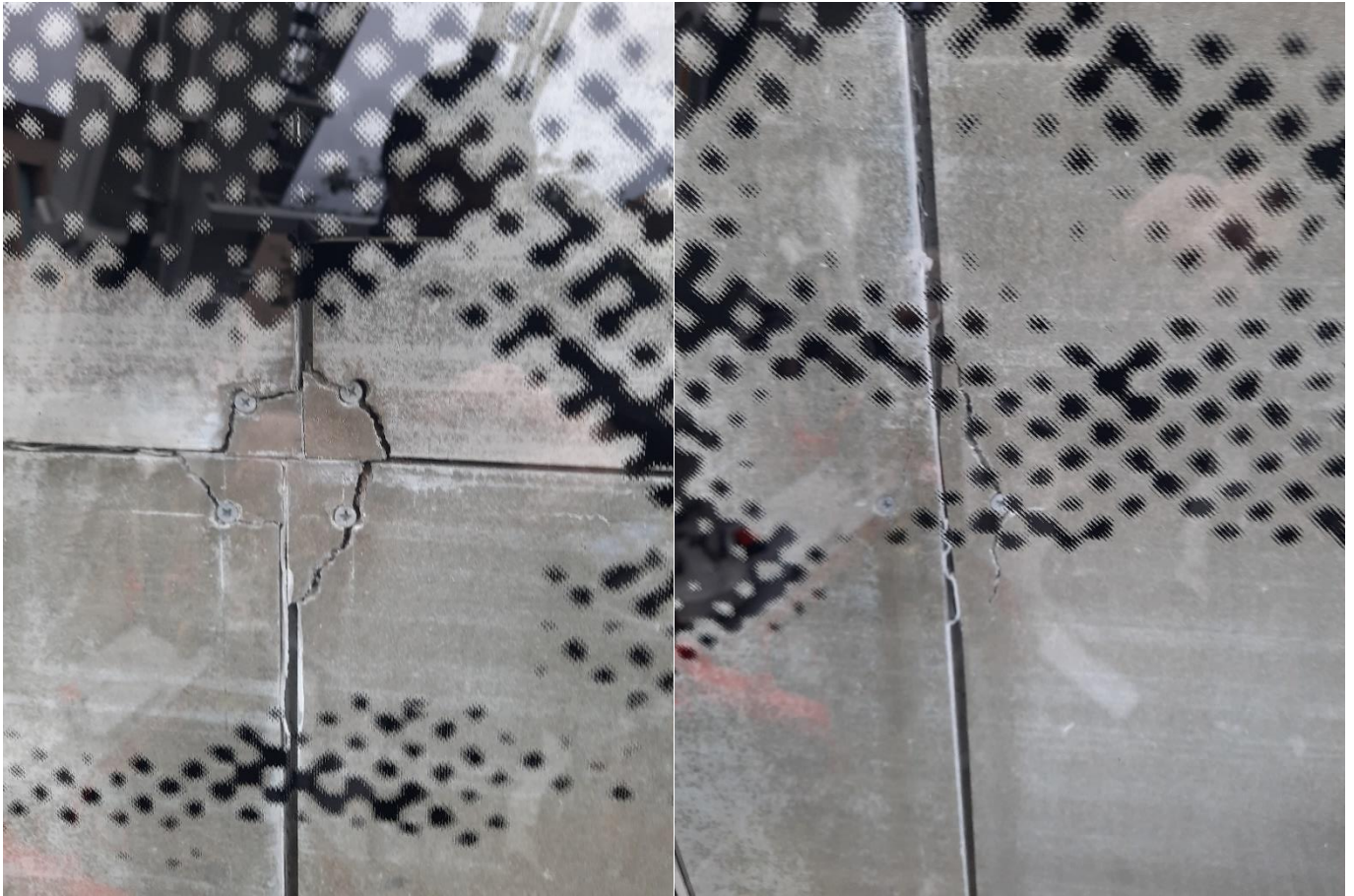
Riva í klædningi aftan fyri glasfasadu.
