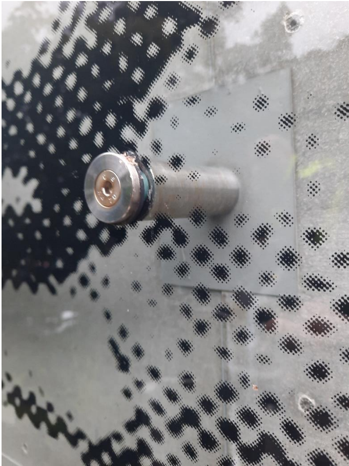
Festi, har glas er sjúnkað og gummipakningur er gliðin.
