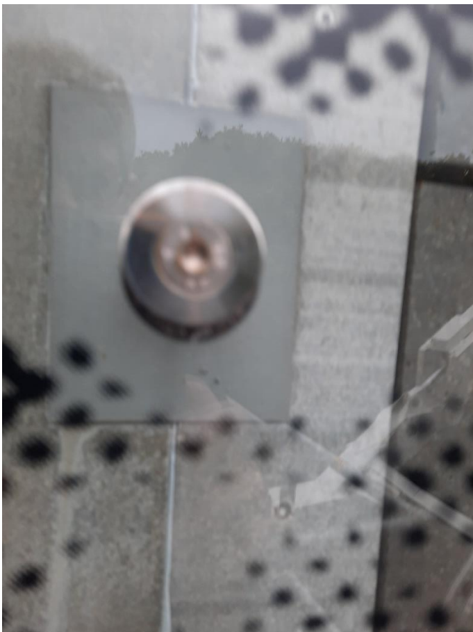
Festi, har glas er sjúnkað og gummipakningur er gliðin.
