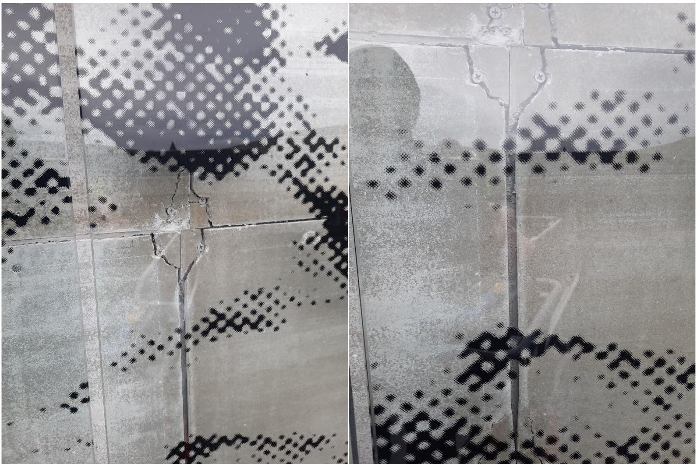
Riva í klæðningi aftan fyri glasfasadu.
