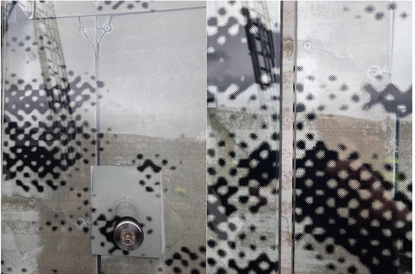
Riva í klædningi aftan fyri glasfasadu.
