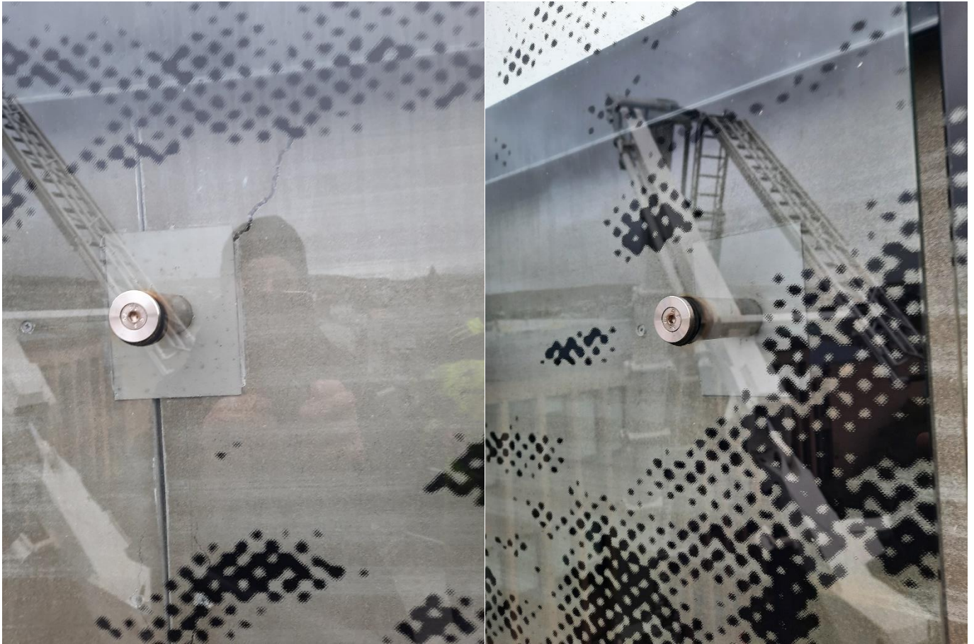
Riva í klæðningi aftan fyri glasfasadu.
