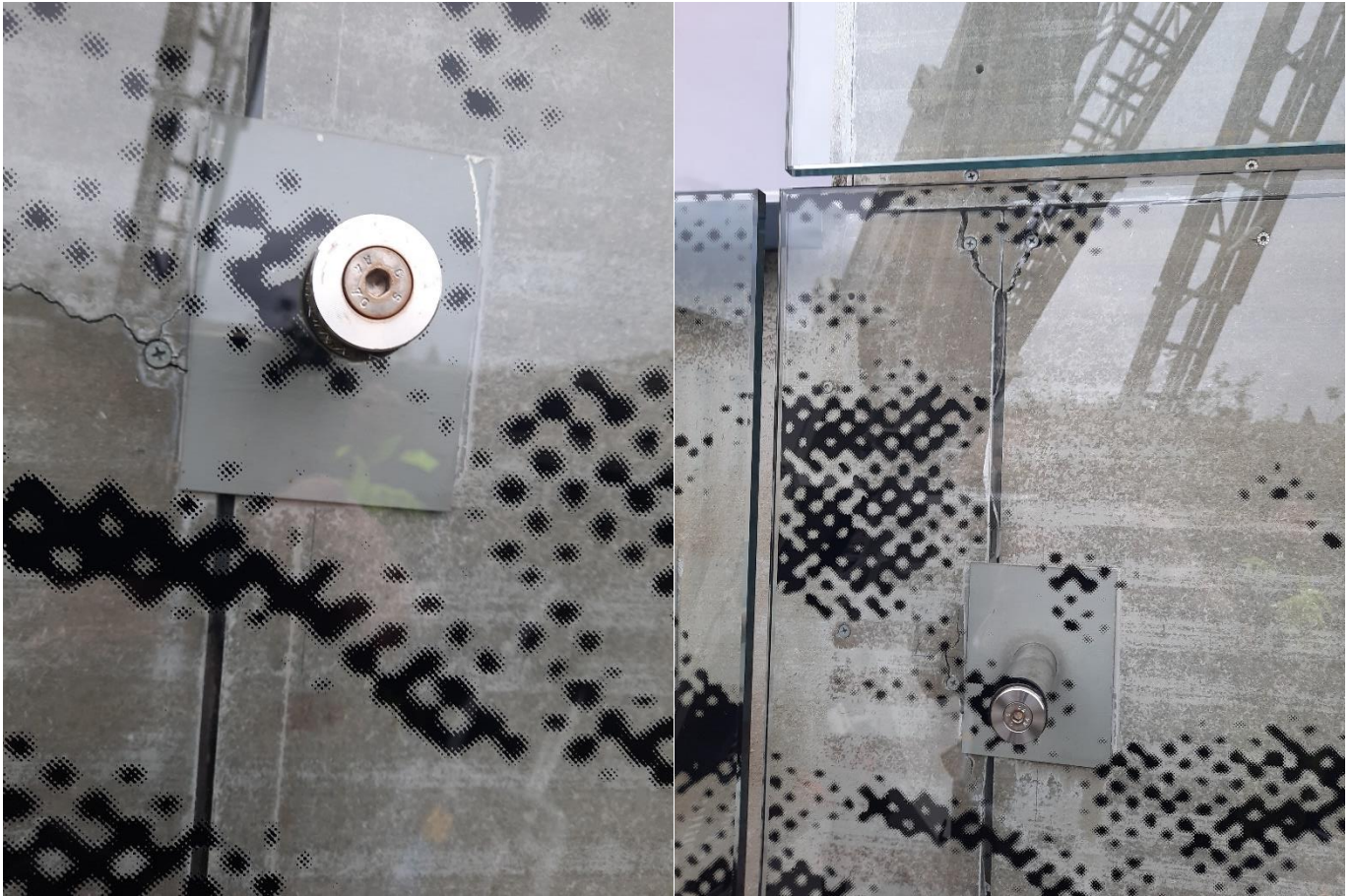
Riva í klædningi aftan fyri glasfasadu.
