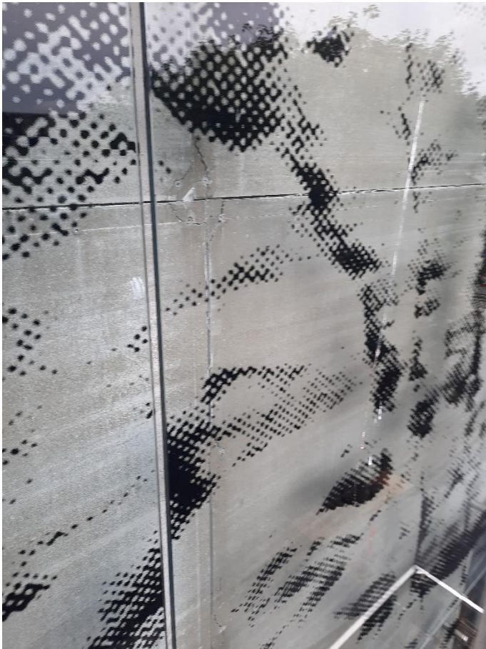
Ríva í klæðningi aftan fyri glasfasadu.
