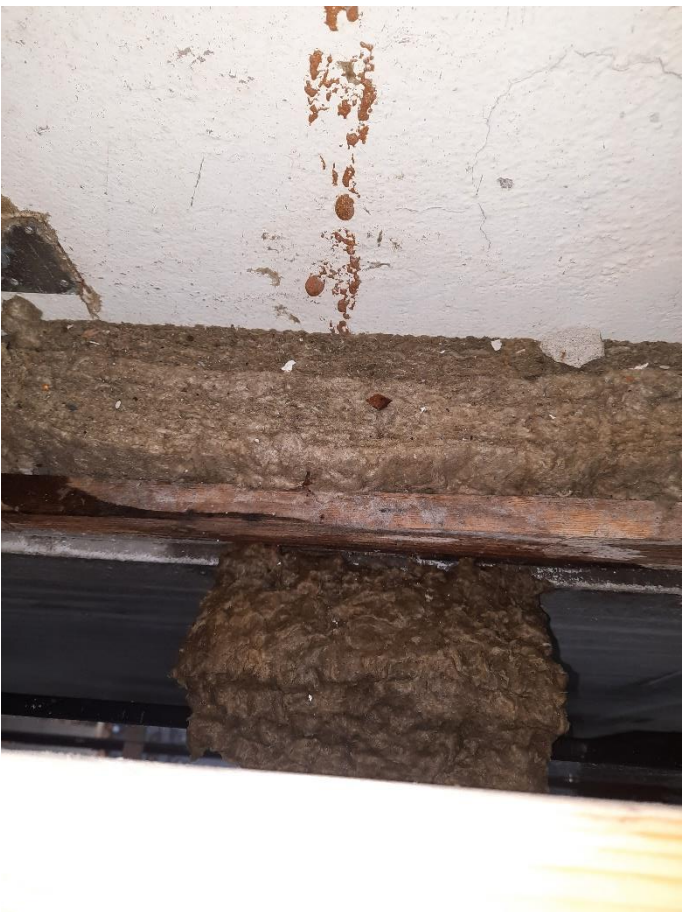
Rivur í betongveggi og væta í timbri
