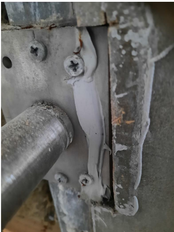
Riva í betongveggi og festi av berandi stáli til betongvegg
