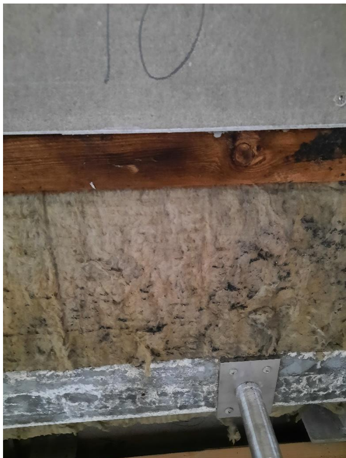
Rot í timbri, soppur í isolering
