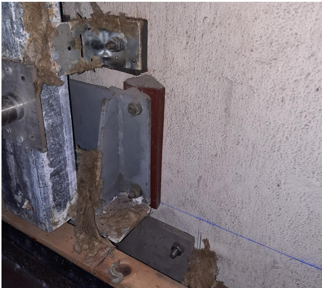
Fótbeslag og loddrættur RHS-profilur
