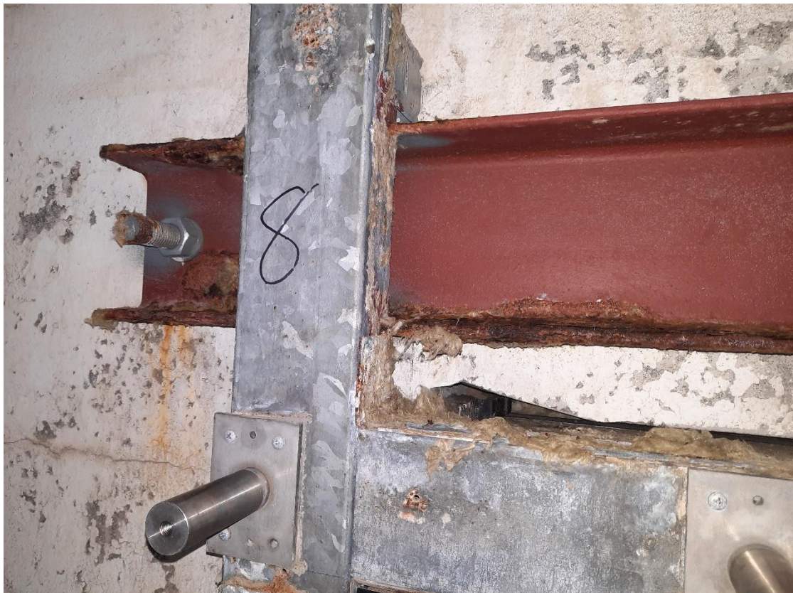
Svart stálfesti yvir vindeyga. Tæring í stáli. Eksentrískt festi
