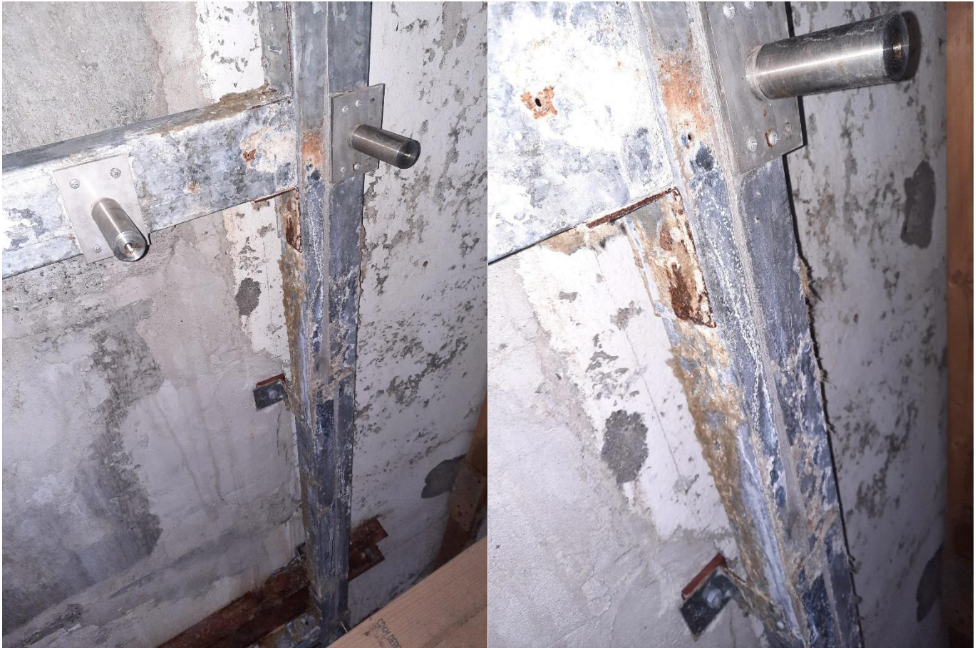
Svart stálfesti yvir vindeyga. Tæring í stáli. Eksentrisk festir
