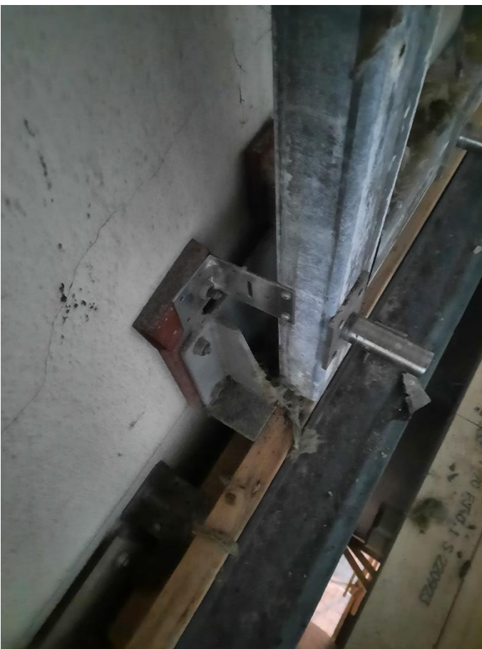
Riva í betongveggi og festi av berandi stáli til betongvegg
