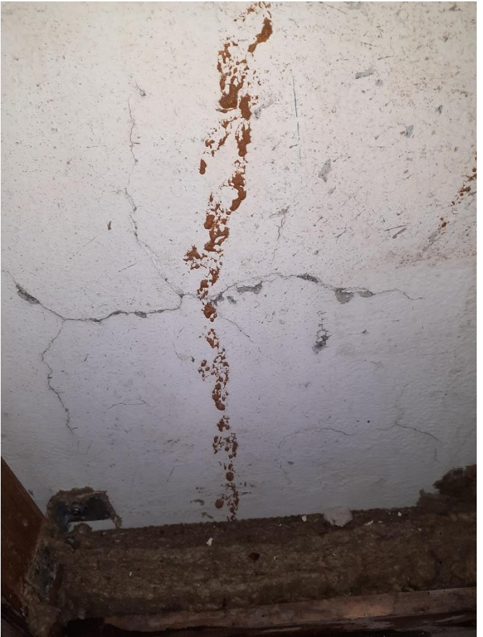
Festi av stáli í timburkonstruktión við tekju. Rivur í betongveggi
