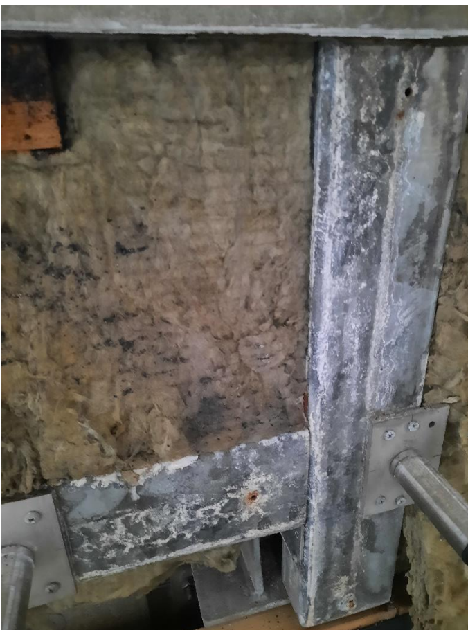
Rot í timbri, soppur í isolering
