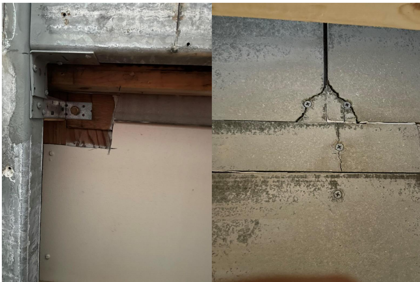
Festi av berandi stáli í timburkonstrukción. Rivur í bakplátu
