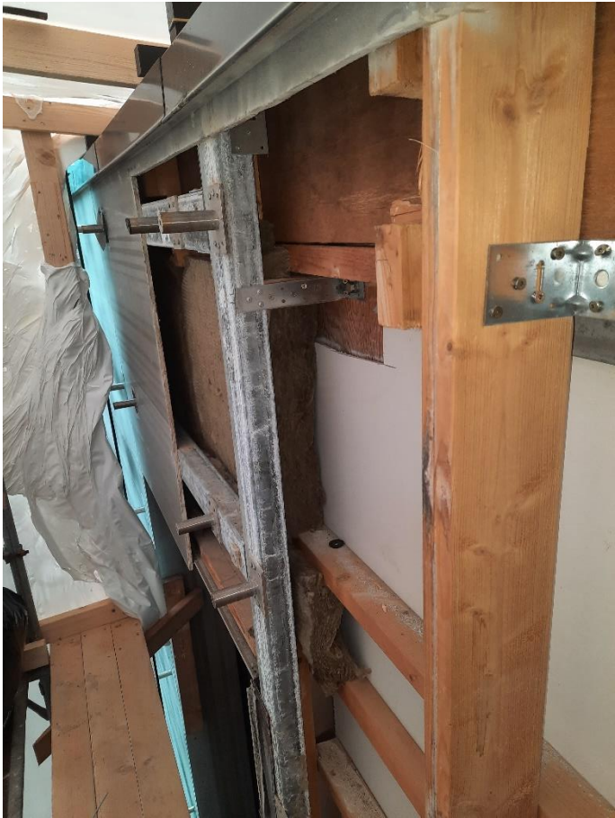
Festi av stáli í timburkonstruktión við tekju. Rivur í betongveggi
