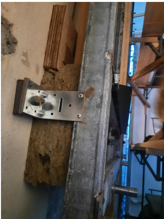
Festi av berandi stáli til betongvegg
