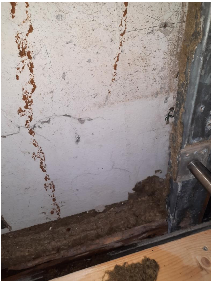
Rivur í betongveggi og væta í timbri
