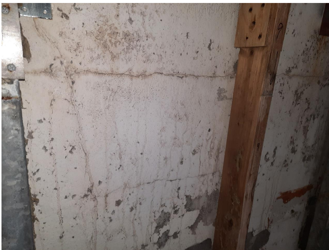
Rivur í betongveggi
