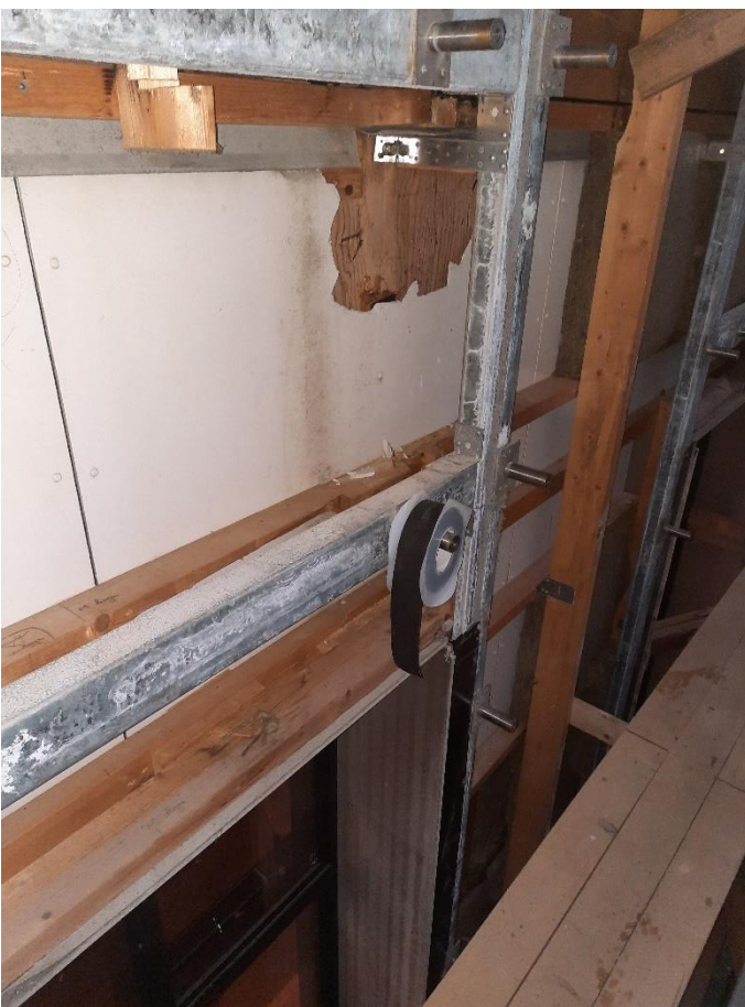
Festi av berandi stáli til betongvegg
