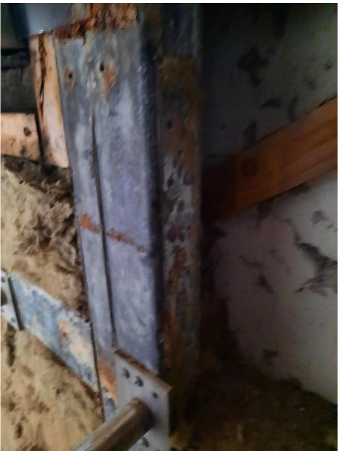
Tæring í stáli, rot í timbri og soppur í isolering
