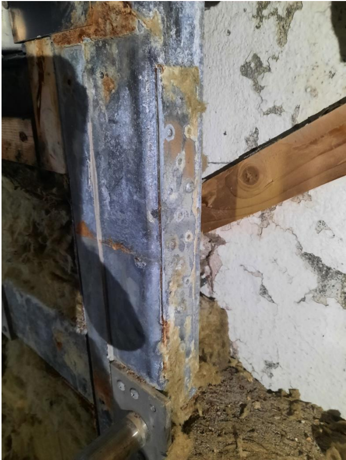
Tæring í stáli og rivur í betongi
