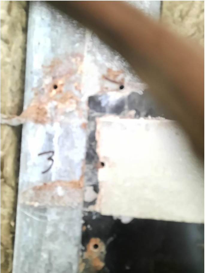
Tæring í stáli og rivur í betongi
