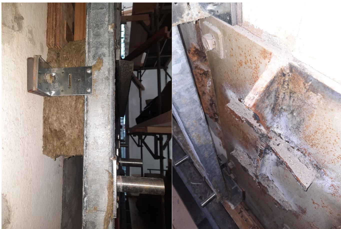
Festi av berandi stáli til betongvegg. Svört stálpláta boltað á betongvegg
