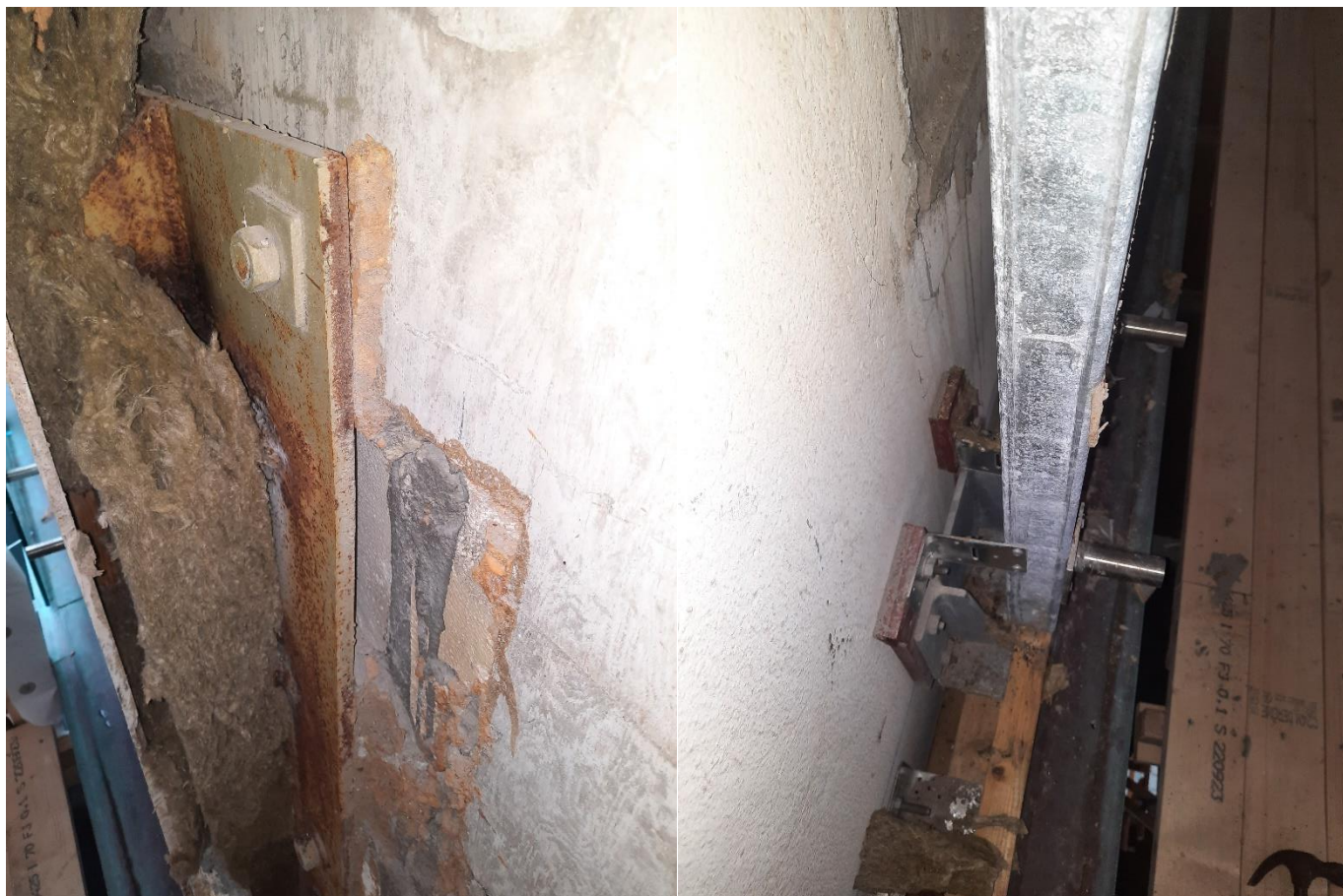
Svört stálpláta boltað á betongvegg. Festi av berandi stáli til betongvegg
