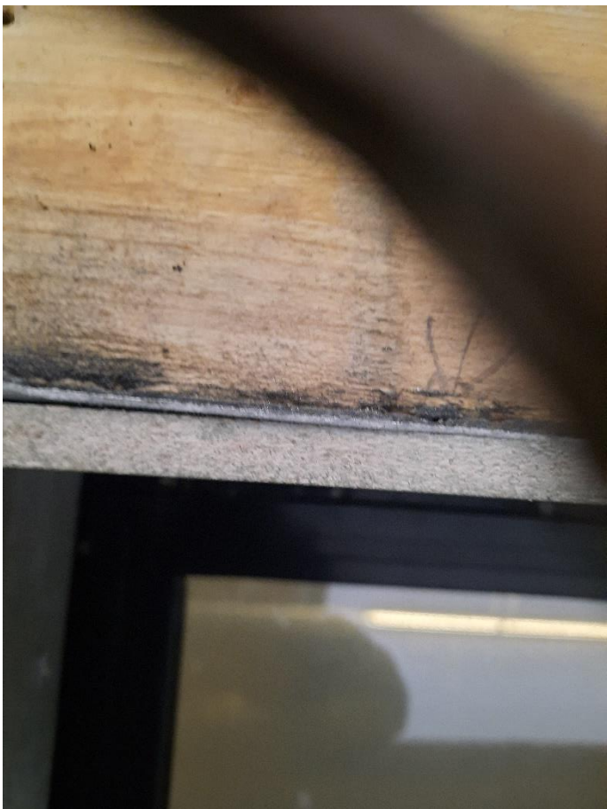
Tæring í stáli, rot í timbri og soppur í isolering
